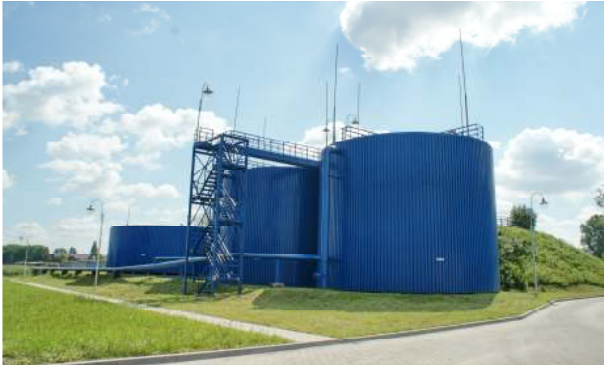
Oczyszczalnia ścieków – foto: Krzysztof Malec
