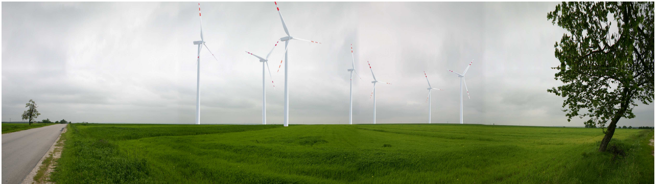
Fot. 2 Widok na obszar „Zmiany planu...” z drogi Zielonki-Gręzów – wmontowane sylwety elektrowni wiatrowych (odległość do elektrowni od ok. 700 m do ok. 2,3 km)
