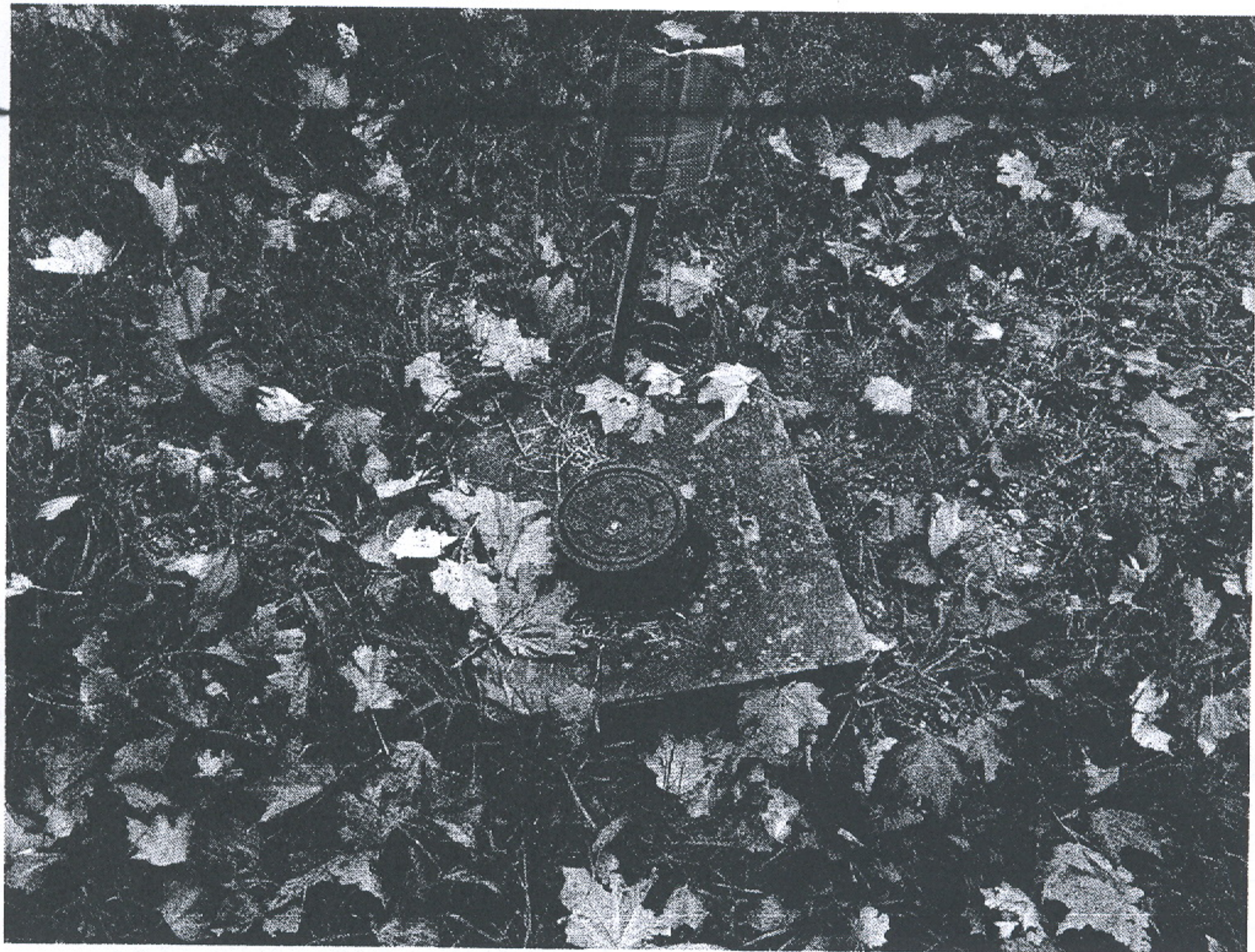
Fot. 4 Podłączenie główne sieci wodociągowej w ul. Marianowskiej
