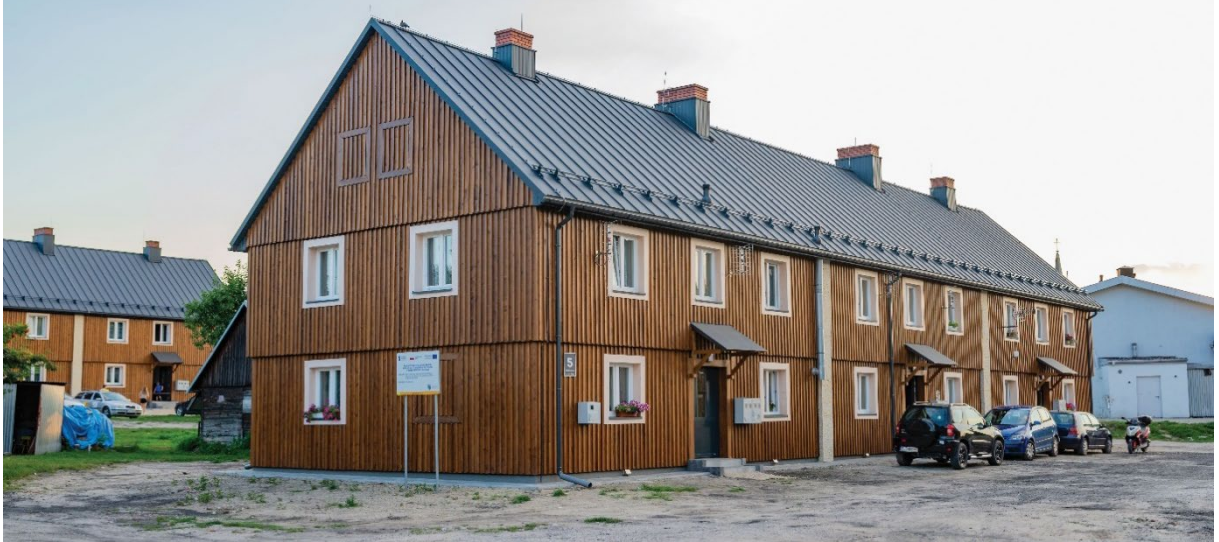
Zdjęcia Nr 6 – Po modernizacją Osiedle Drewniane
