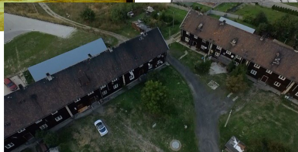
Zdjęcia Nr 5 – Przed modernizacją Osiedle Drewniane
