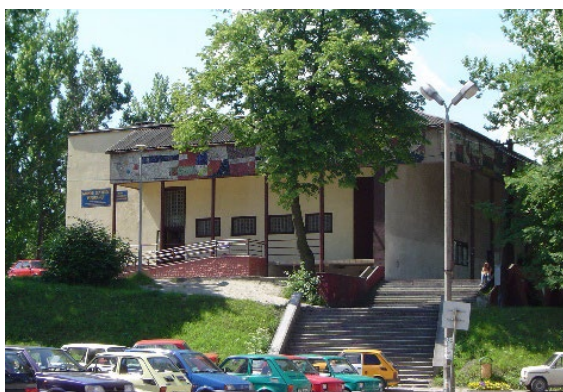
Zdjęcia Nr 3 – SCK przed modernizacją
