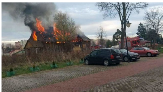
Zdjęcie Nr 14 – Pożaru nieużytkowanego budynku mieszkalnego w Sędziszowie
