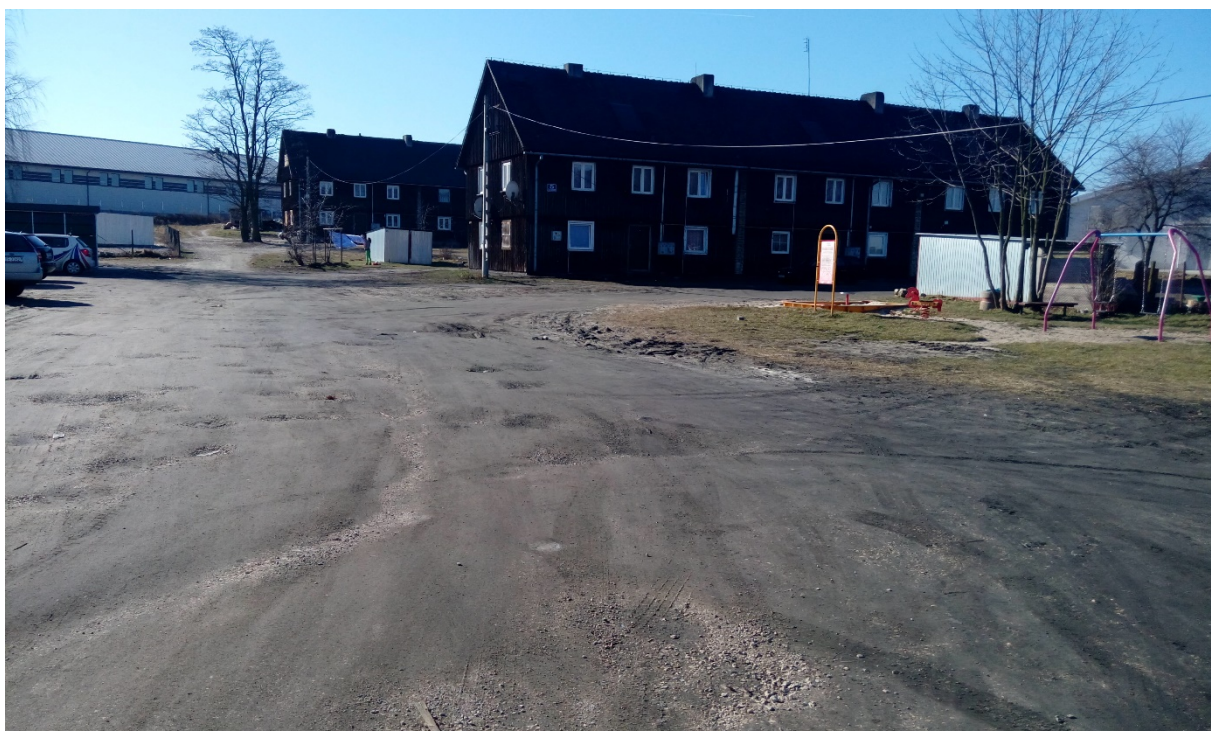
Zdjęcie nr 2. Osiedle Drewniane – fot. Zespół ds. GPR
